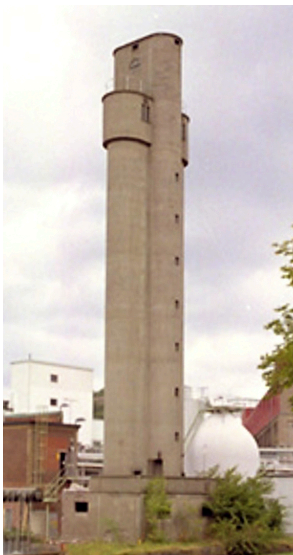
Den karaktäristiska byggnaden på alla sulfittbruk, syratornet. Det här på Papyrus pappersbruk byggt 1939 och rivet 1997. Foto Mölndals stadsmuseum.
