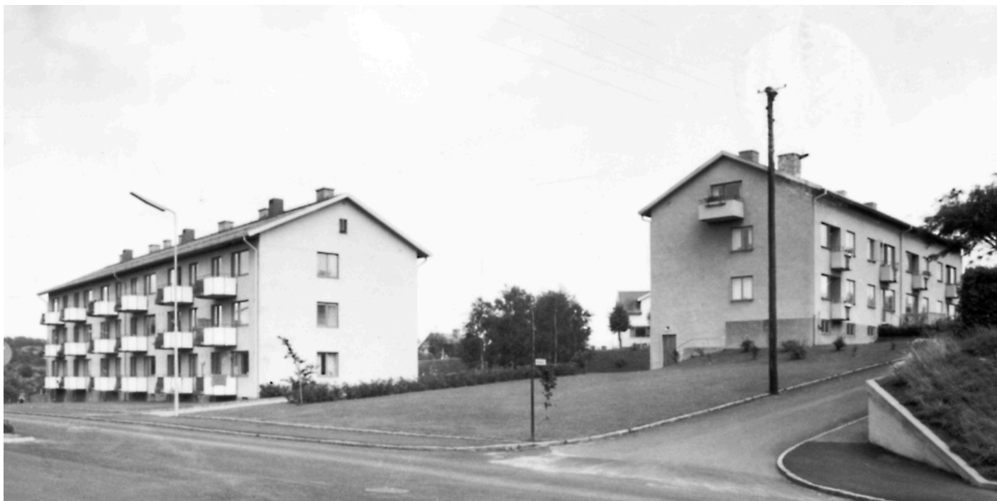
Två fastigheter byggda av AB Papyrus med hyreslägenheter för anställda på Stensjögatan 22 och 24. Foto Lennart Håwi.
