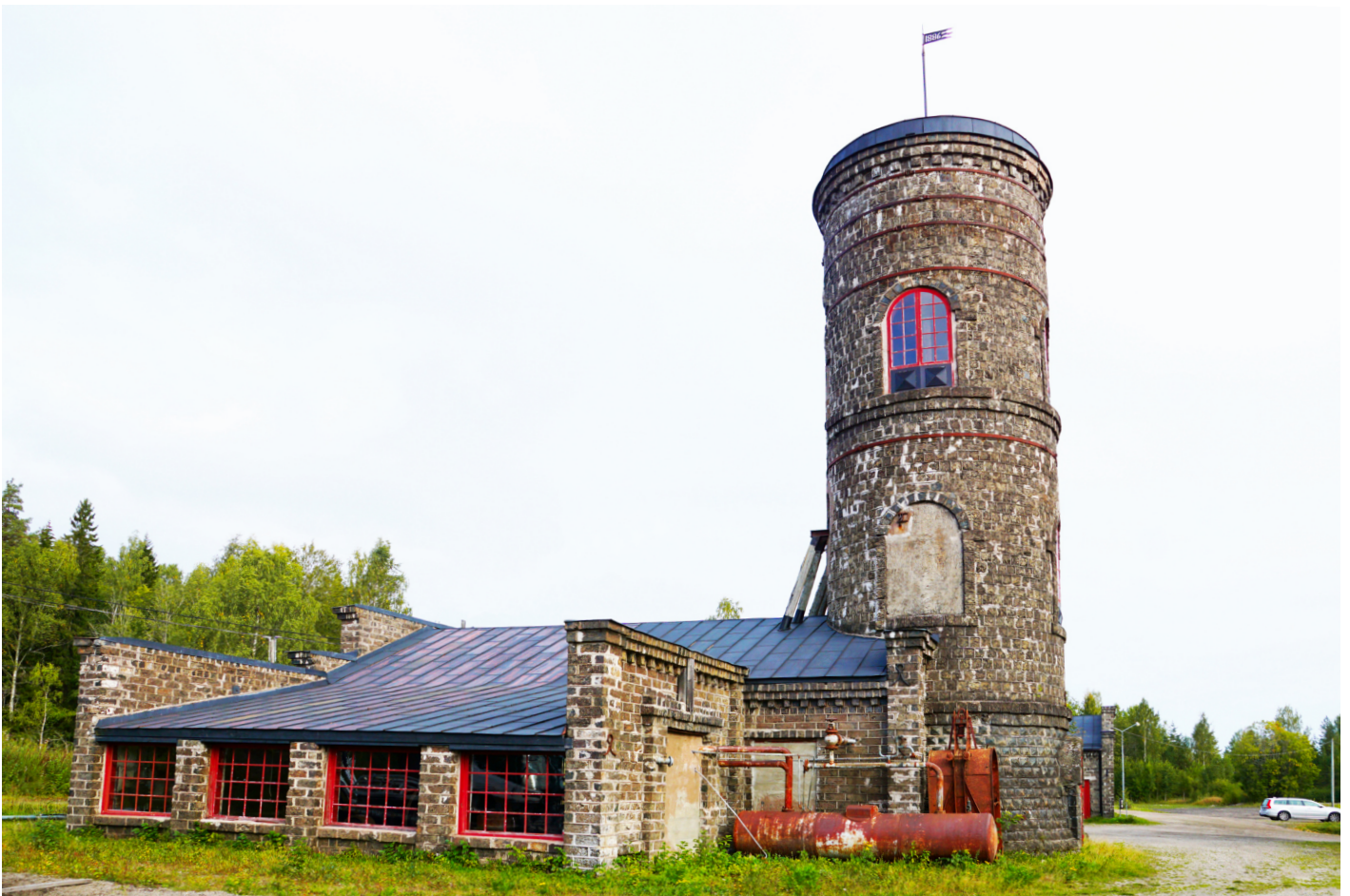
Lave av murad slaggsten över Gröndalsgruvan i Klackberg. Laven byggdes 1886. Den låga byggnaden med fönsterraden till vänster innehåller kompressorrum medan den högre byggnadsdelen är spelhuset.
