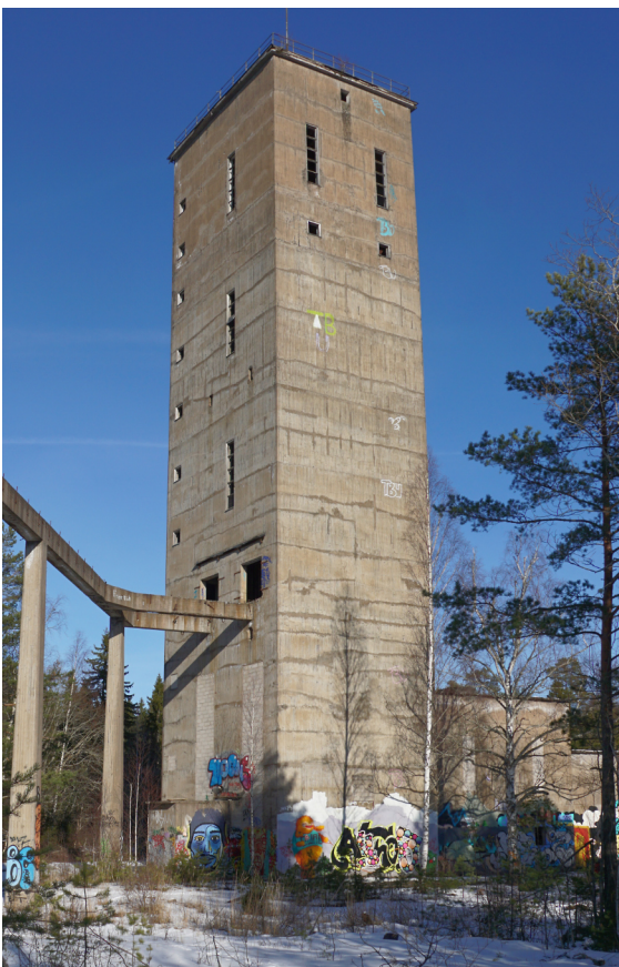
Bergslagsschaktets lave som byggdes 1942-46 vid Ramhälls gruvor.
