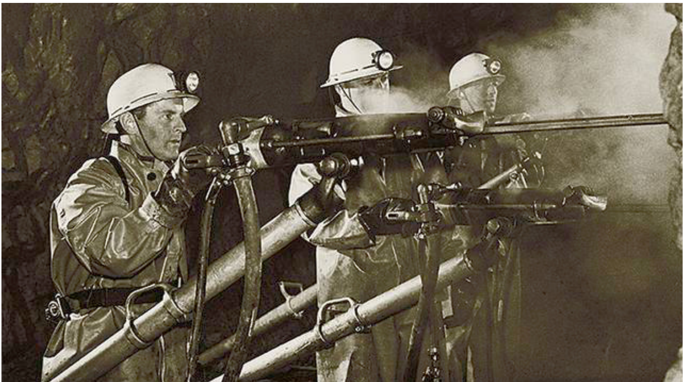
Tunneldrivning enligt den svenska metoden. Lätta bormaskiner med knämatning. Foto Atlas Copco.
