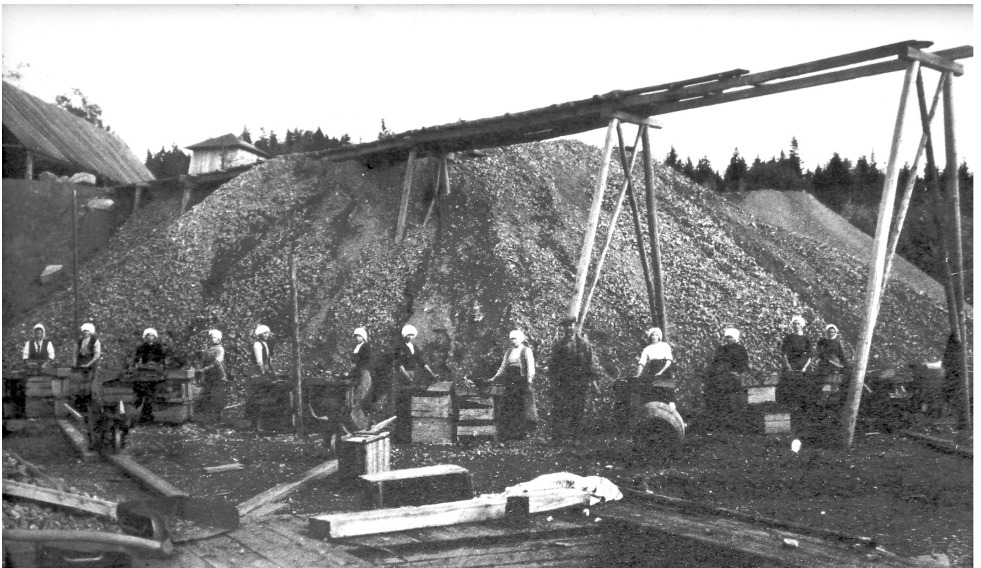
Skrädning av malm under tidigt 1900-tal. Lägg märke till kvinnornas dominans, tidigare arbetade många barn med skrädning. Antingen hade barnen flyttats inför fotograferingen eller hade de blivit utkonkurrerade av kvinnor. Foto från Wikipedia.
