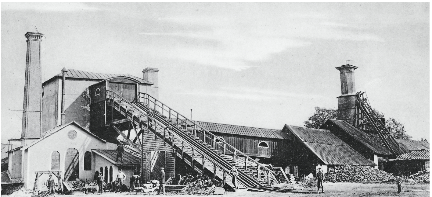
Hyttan i Gysinge. Till vänster gjuteri och masugn och till höger rostugn. Foto från Järnvägmuseet.
