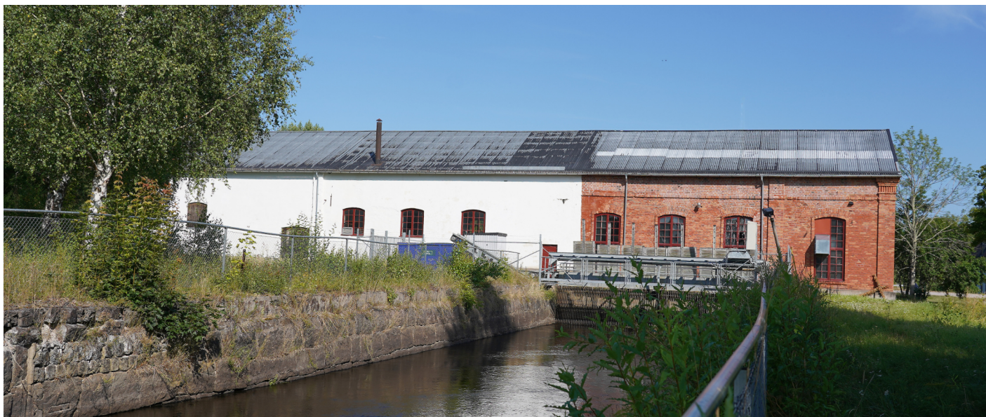
Kraftstationen i Gysinge. På bilden syns den stensatta inloppskanalen och hela kraftstationsbyggnaden. Den del av byggnaden som är i rött tegel inrymmer vattenkraftverket, den vita delen är ugnschallen där den kjellinska induktionsugnen står.
