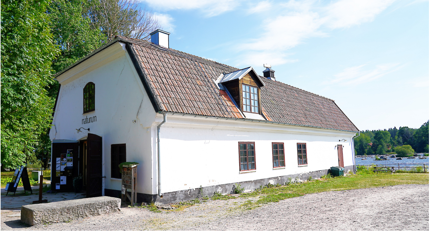
Den magasinsbyggnad vid Dalälven Länsstyrelsen i Gävleborgs län för sitt Naturum hyr av PRO.
