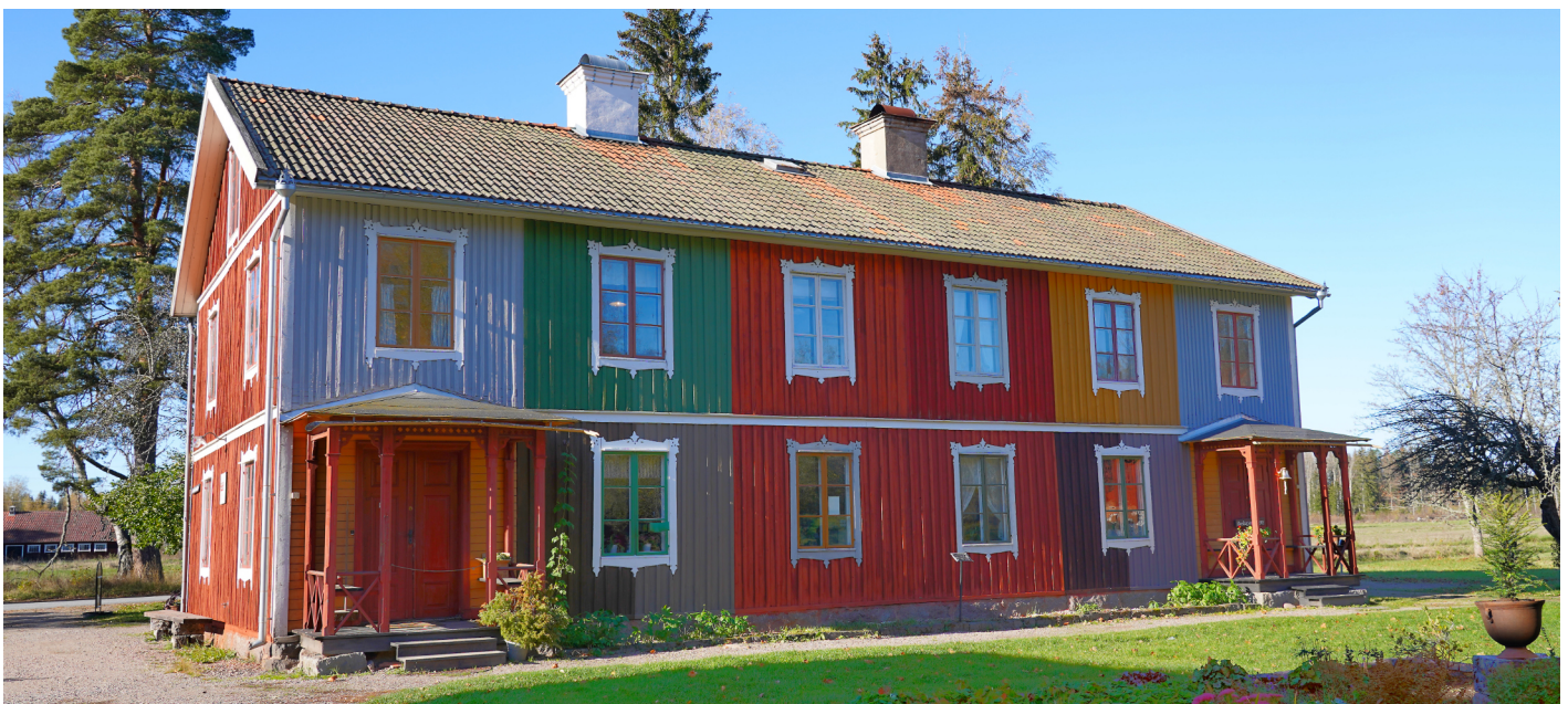
Det fjärde av kvarvarande bostadslängorna för sulfitarbetarna i Byggena. Centrum för Byggnadsvård använder huset som butik och använder utsidan till att visa färgprover på sina produkter.
