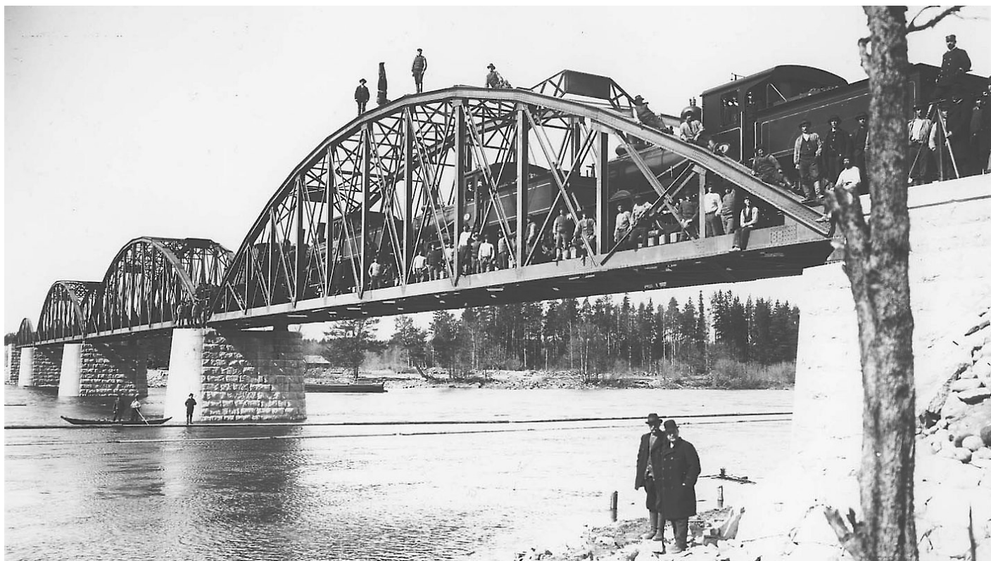
Provbelastning av SGGJs järnvägsbroar över Dalälven år 1901. Järnvägen och broarna var klen dimensionerade, maxfarten på spåren var 50 km/tim (ökades senare till 60 km/tim) och på broarna 10 km/tim. Foto Järnvägsmuseet.
