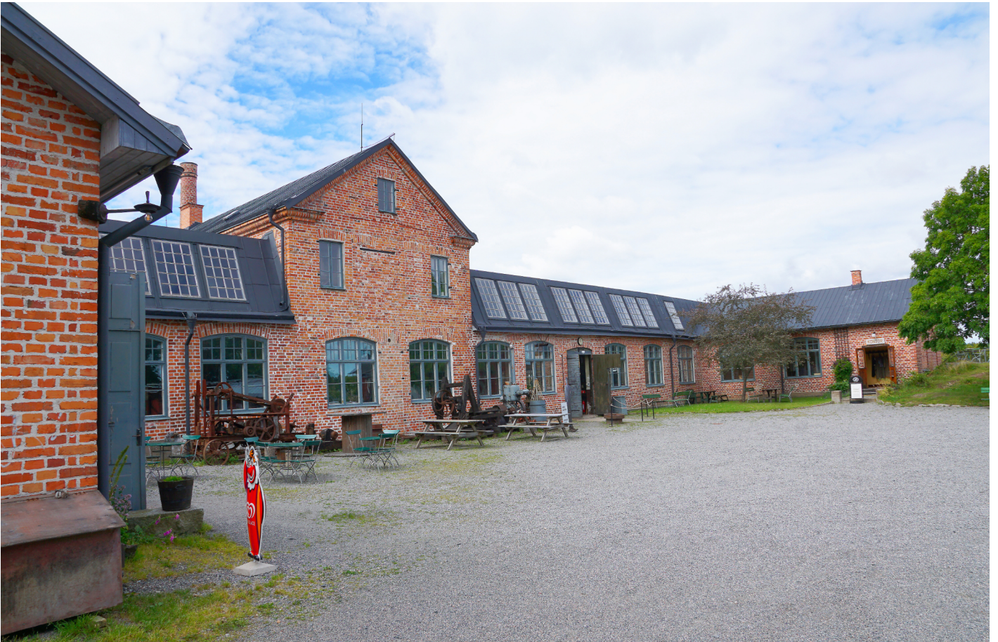
Verkstaden på Södra Berget fotograferad från öster. Till vänster gaveln av smedjan, maskinverkstaden och längst till höger kontoret.
