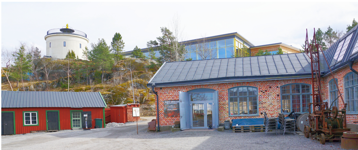
Smedjan, den södra flygeln av verkstadsbyggnaden på Södra Berget. Det vita tornet är Norrtäljes gamla vattentorn som på taket har Sveriges enda fungerande flygfyr. Den gula fyren har renoverats med hjälp från bland andra Pythagoras Vänner.
