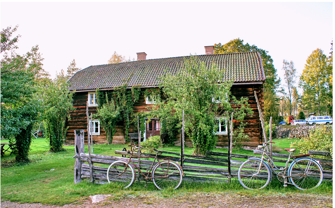
Mangårdsbyggnaden i Ösjöfors, bild av den södra (tjusiga) sidan med paradingången.
