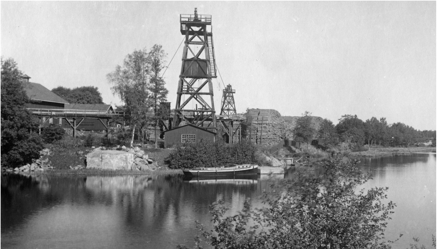
Vedgården år 1926 i Sörstafors pappersbruk vid Kolbäckån. Kabelkranens två torn vid vedtravarna. Foto Tekniska Museets arkiv.
