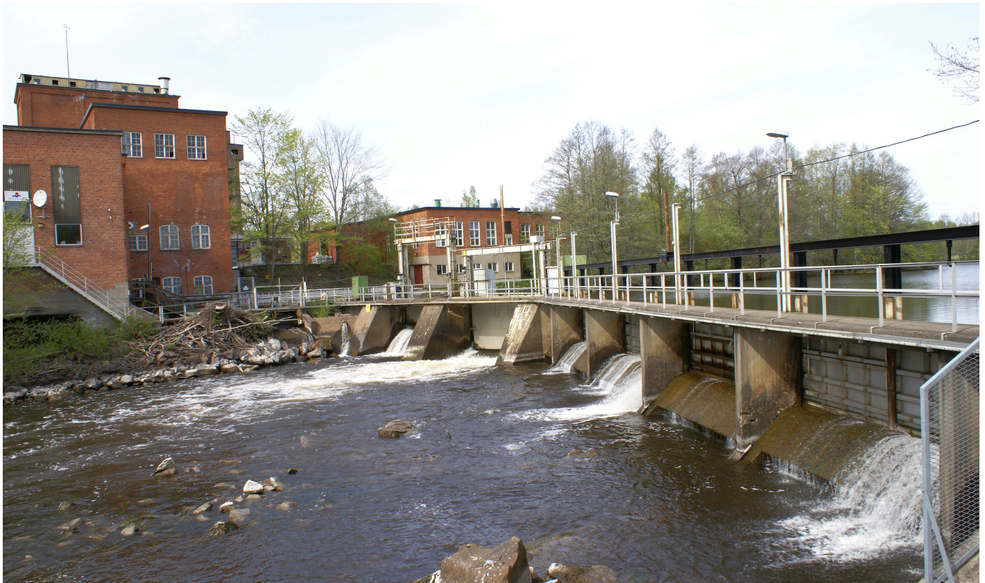
Dammanläggning i Kolbäcksån vid Sörstafors pappersbruk. Av bruket syns vattenkraftverket, sliperiet och renseriet.
