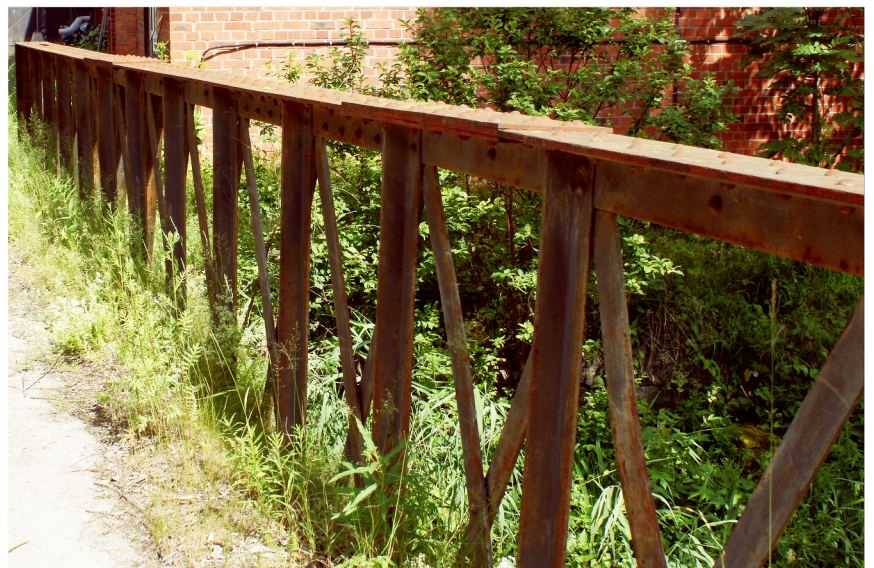
Räcke på stålbro över Svenbybäcken i Sörstafors.
