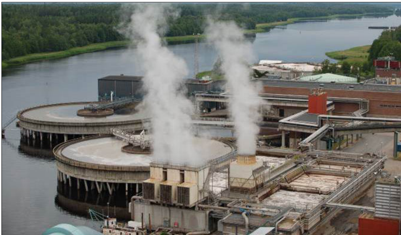
Vattenreningsanläggningen vid Hallsta pappersbruk. Foto Håkan Lundén.
