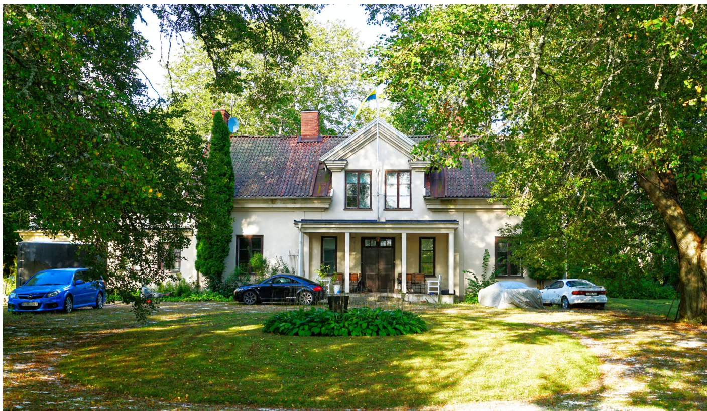
Före detta förvaltarbostaden (för inspectorer, förvaltare och disponenter) i Karmansbo.
