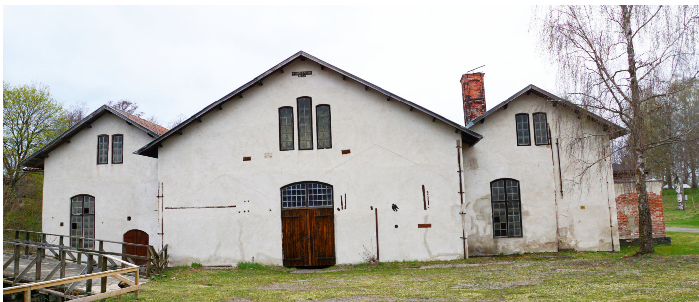
Smedjan i Karmansbo. Den smedja som byggdes upp 1812 var lika bred som mittskeppet. Alldeles bakom björken till höger fanns den höga skorstenen som emellertid revs år 1973 på grund av den stora rasrisken.
