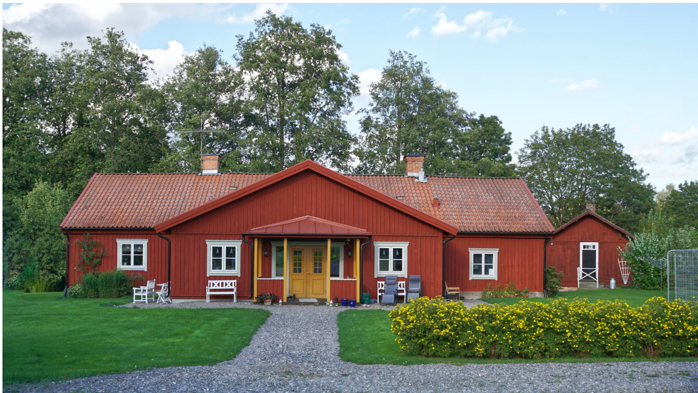
Byggnad nummer 17 i Karmansbo som från början rymde lägenheter för fyra lantarbetarfamiljer har efter ett par renoveringar resulterat i en privat bostadslägenhet.
