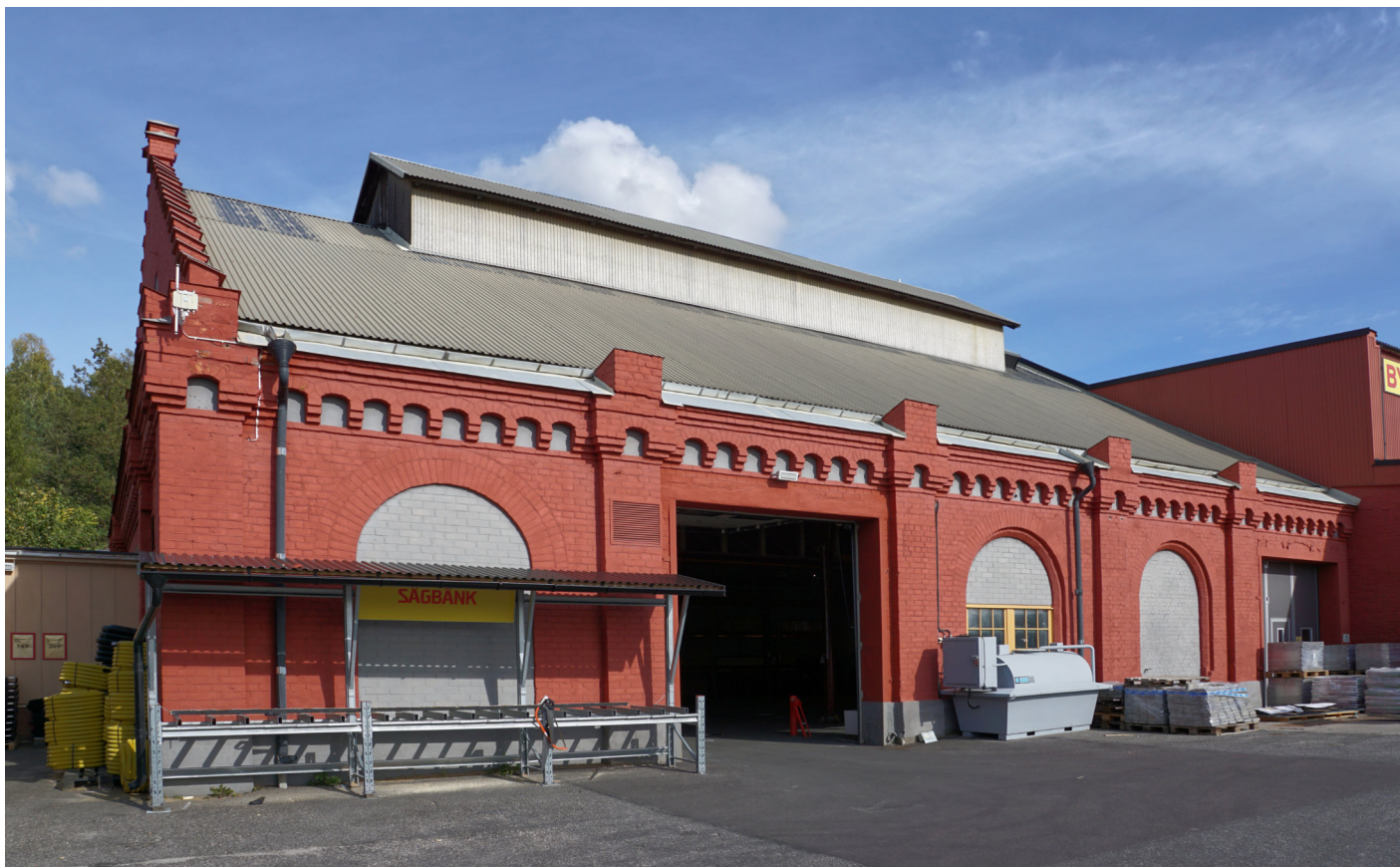
Det finns några få byggnader kvar på platsen där Karmansbo hytta fanns men de är ombyggda för nya ändamål.
