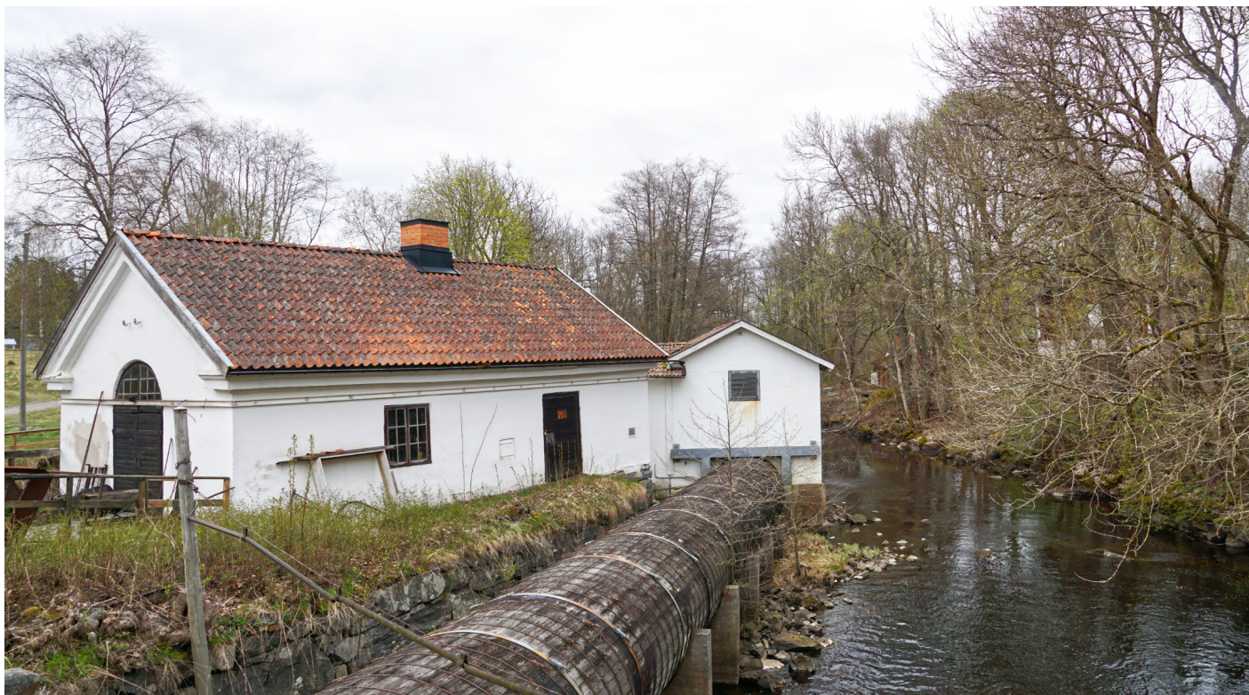
Vattentuben går in i gaveln på turbinhuset mitt i bilden. Byggnaden till vänster är klensmedjan.
