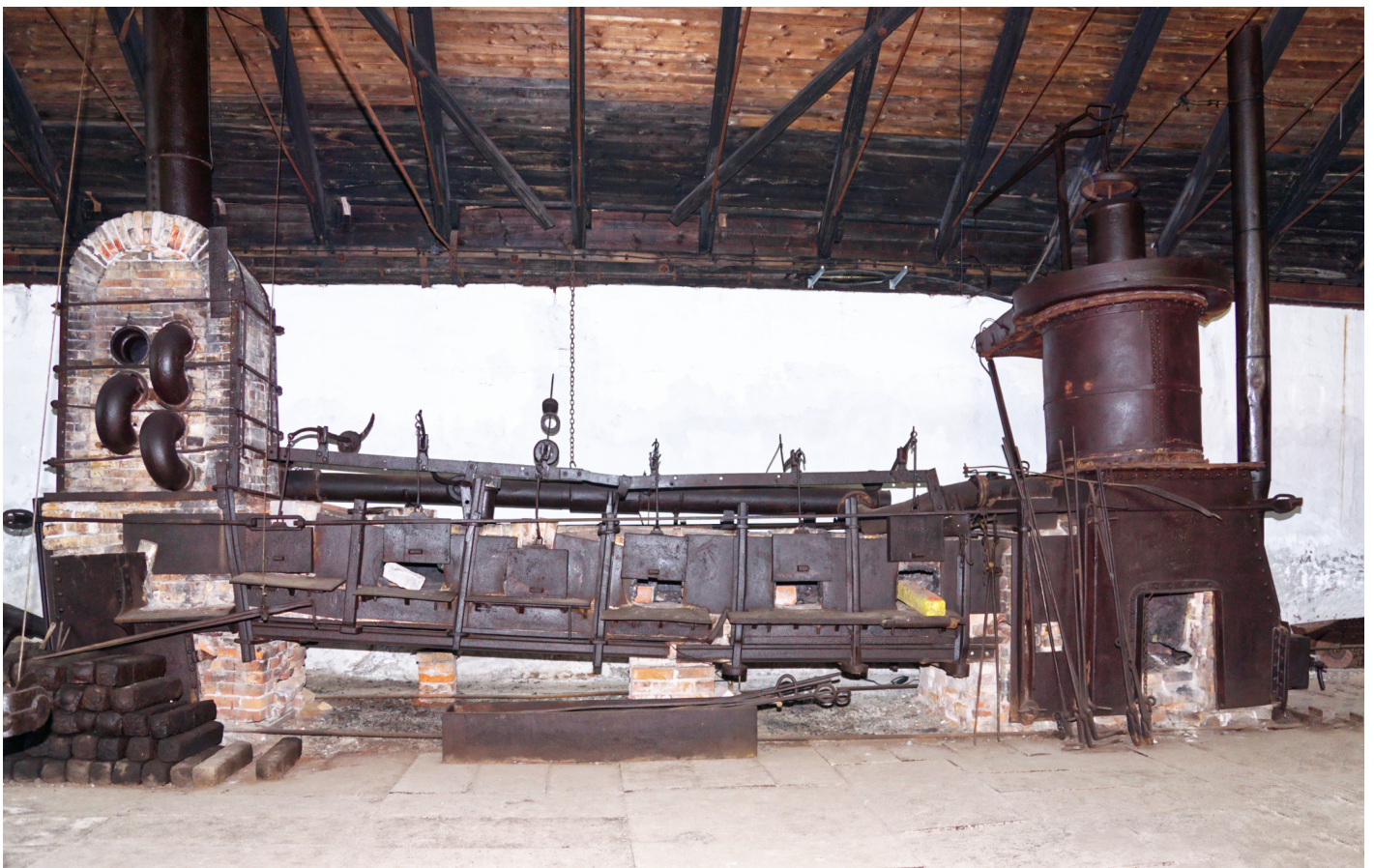
Puddelugn i Surahammars bruksmuseum. Den stående cylindern till höger på ugnen är en gasgenerator som alstrar gengas genom torrdestillation av trä eller kol. Gengas är bränslet i puddelugnen. Tegelkonstruktionen till vänster förvärmer förbränningsluften med hjälp av ugnens avgaser. Genom luckorna i ugnen matas tackjärn in i ugnen och här sticks spett in för att röra om i järnsmältan.
