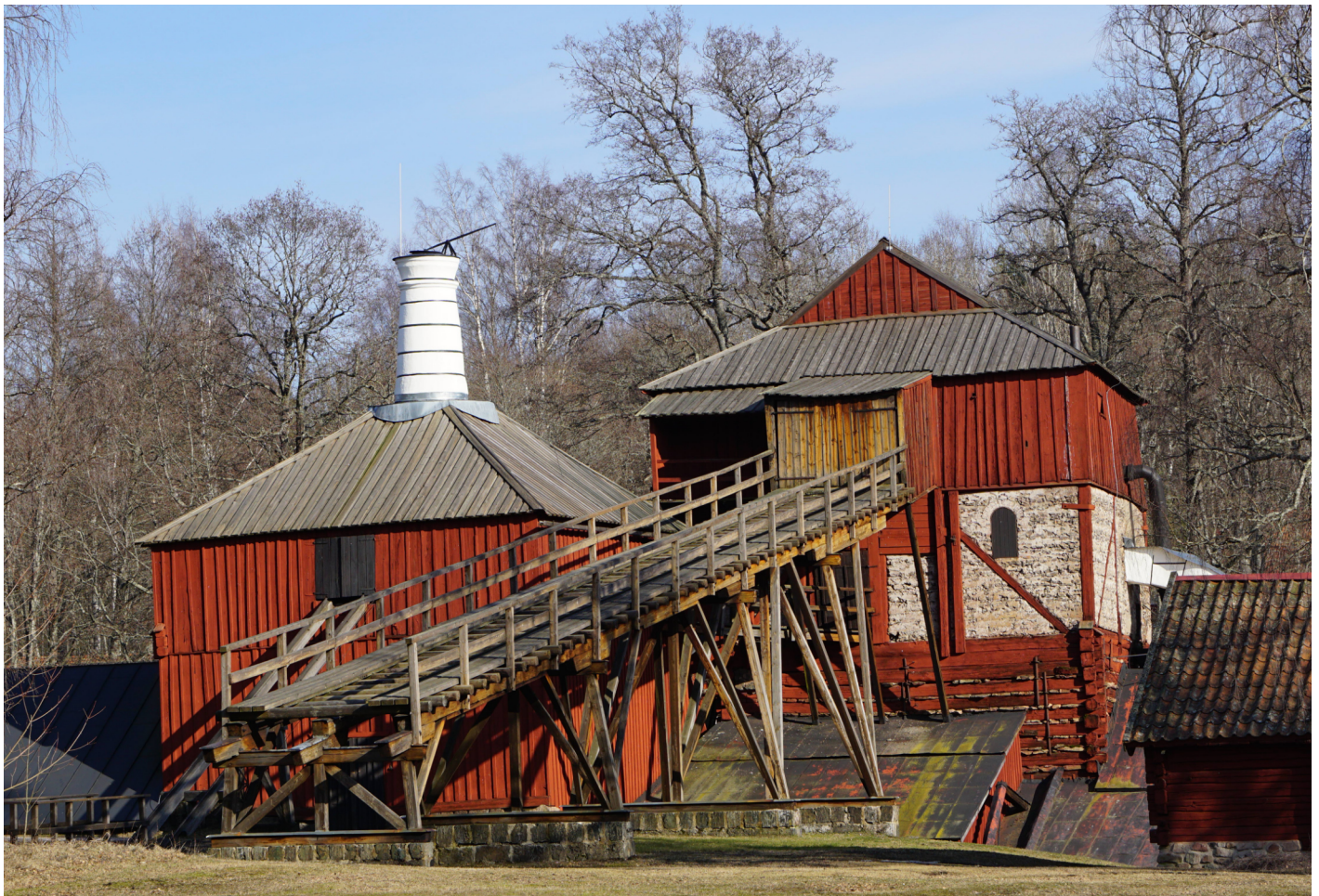
Hyttan i Ängelsberg. Till vänster rostugnen och till höger masugnen av mulltimmertyp.
