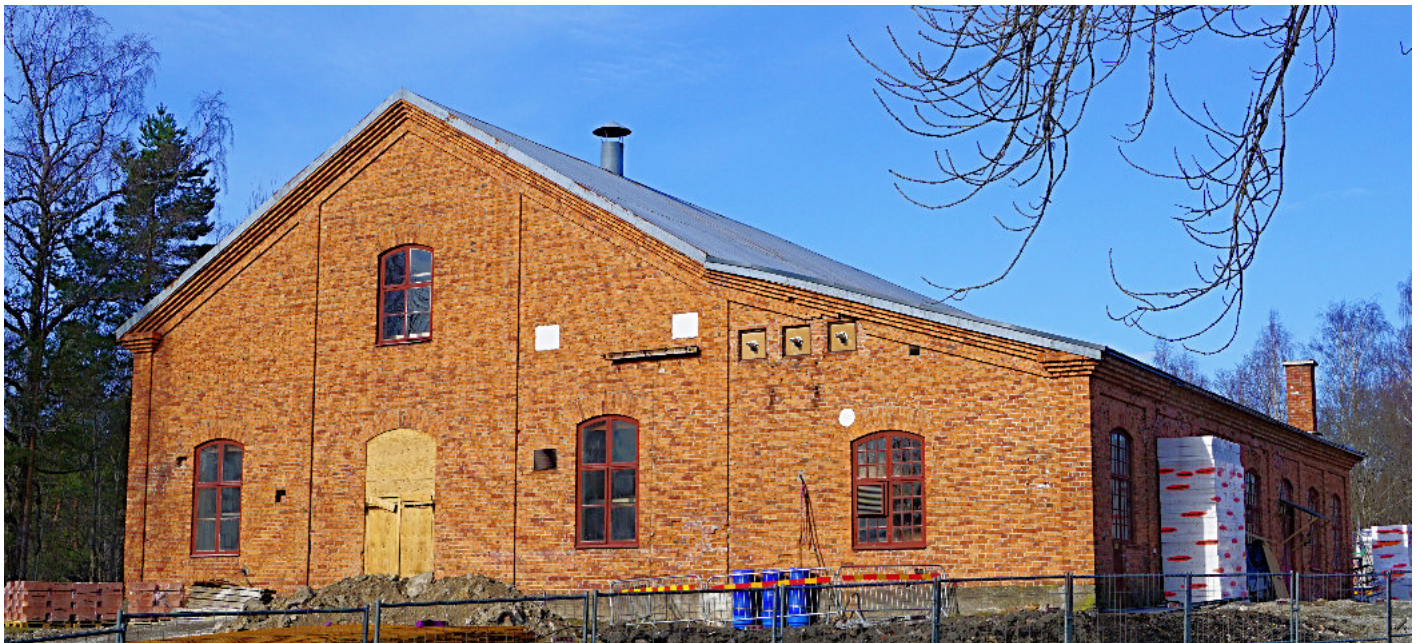
Ventilfabriken, före detta lancashiresmedjan, inför ombyggnad.
