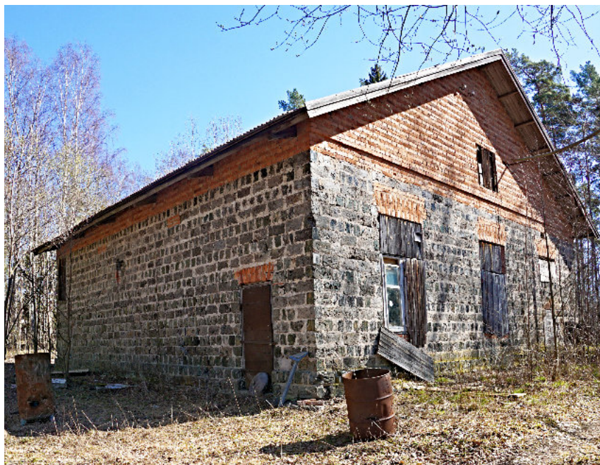
Maskinhuset till ångsågen i Ängelsberg. Här fanns både ångpanna och ångmaskin.
