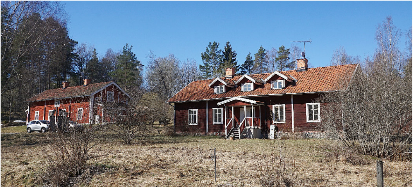
Slaggarbo 1 och Slaggarbo 2, två flerbamiljshus för anställda vid Engelsbergs bruk.
