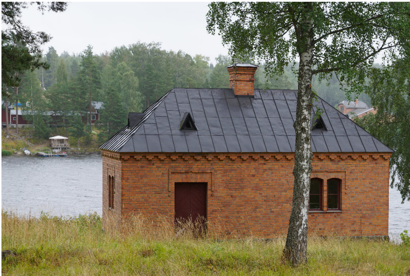
Bryggstugan på Oljeön, en elegant byggnad att tvätta och baka i.
