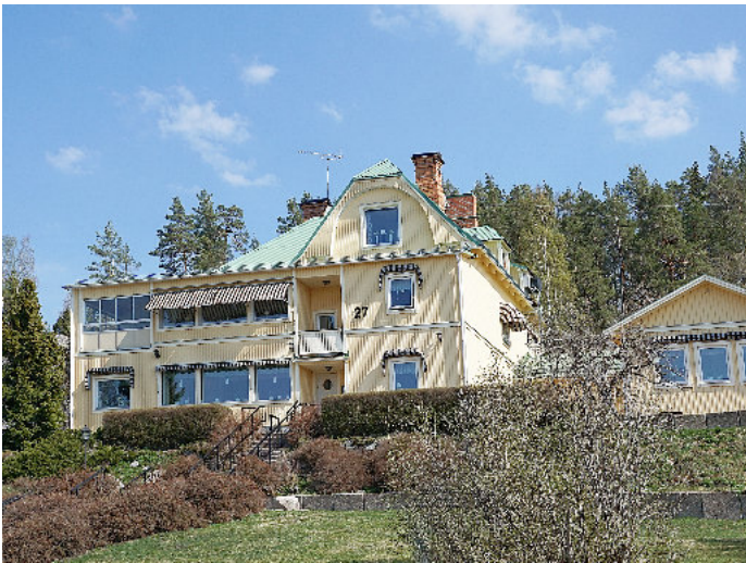
Bergslagsgården, tidigare hotell och pensionat. Numera sjuk- och behandlingshem. Det finns även med nyare byggnader för boende och behandling vid vägen genom Ängelsberg.
