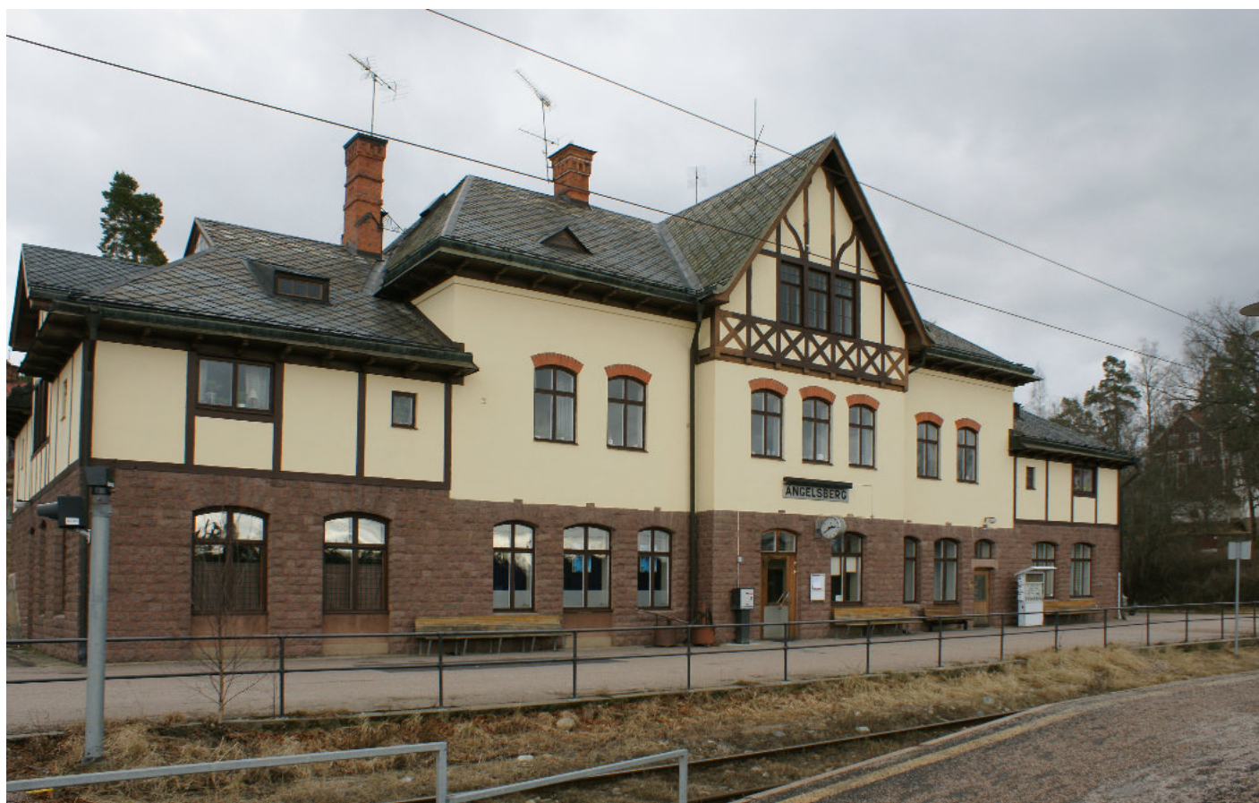
Det nya stationshuset i Engelsberg sett från järnvägen.
