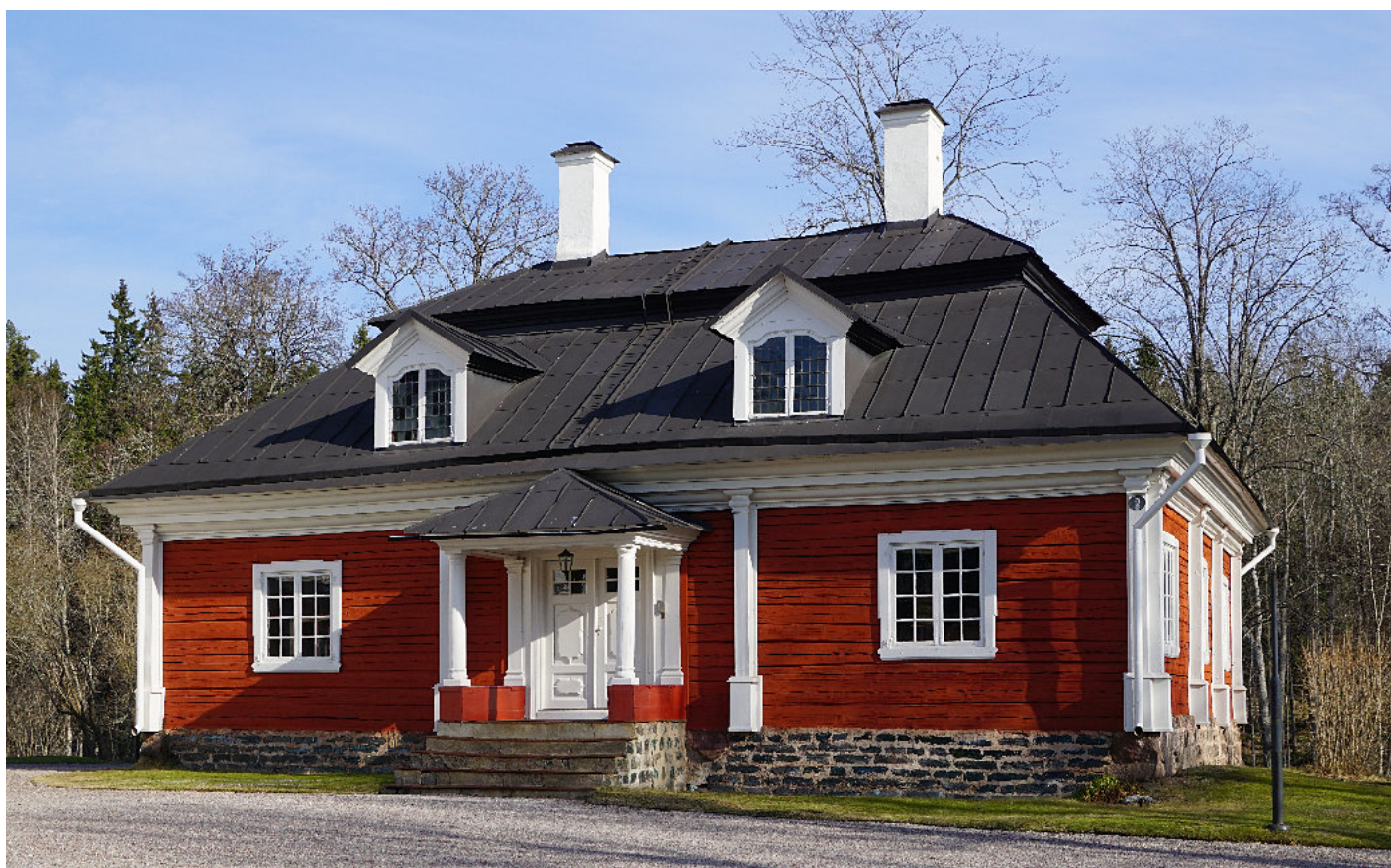
Engelbrektsflygeln eller östra flygeln, den andra av brukets äldsta byggnader från cirka 1700. Den utgör herrgårdens kök.
