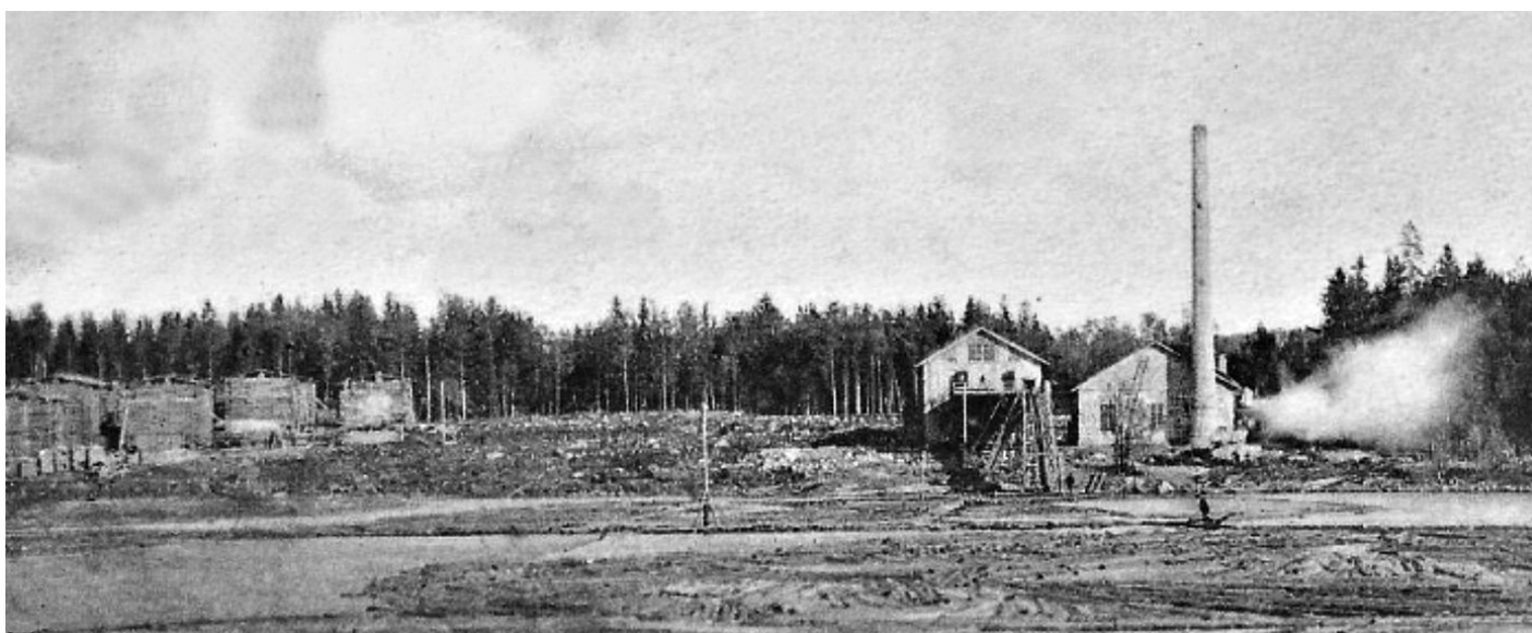
Ångsågen i Ängelsberg. Från höger till vänster maskinhus, sågverk och bräddgård. I Åmänningens vatten ligger flottade timmerstockar och väntar på att bli uppdragna till sågverket med kedjetransportören. Foto efter gammalt vykort.
