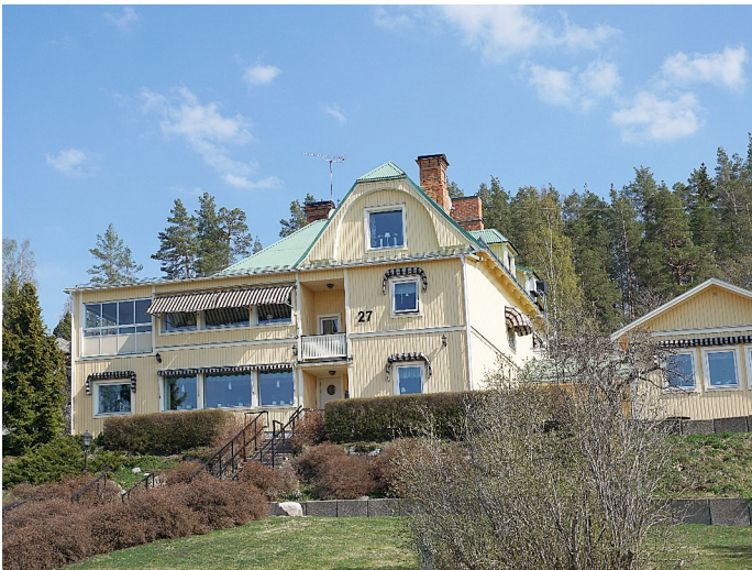
Bergslagsgården, tidigare hotell och pensionat. Numera sjuk- och behandlingshem. Det finns även med nyare byggnader för boende och behandling vid vägen genom Ängelsberg.
