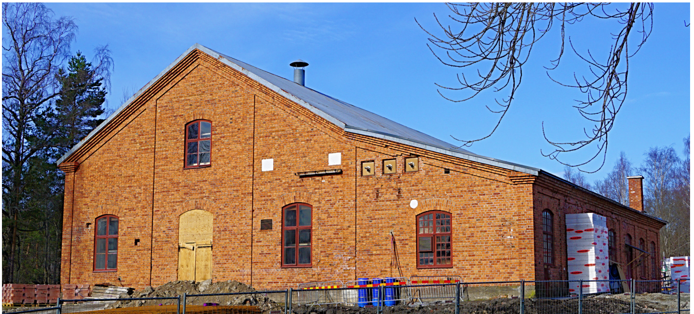
Ventilfabriken, före detta lancashiresmedjan, inför ombyggnad.
