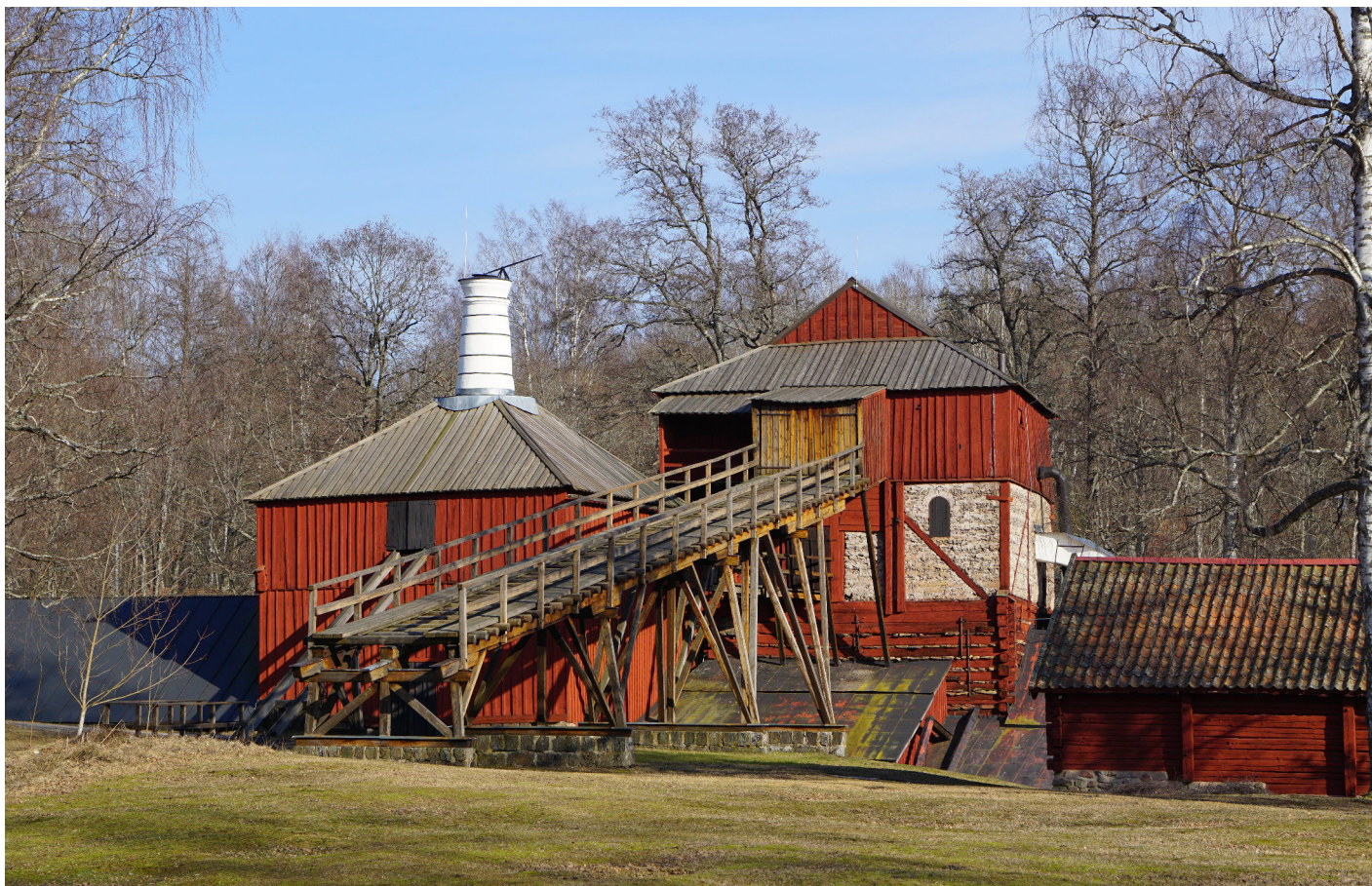
Hyttan vid Engelbergs bruk med rostugn till vänster och masugn till höger. Under det svarta taket längst till vänster finns malmbåsen. Den låga röda byggnaden längst till höger är masmästarens kontor.
