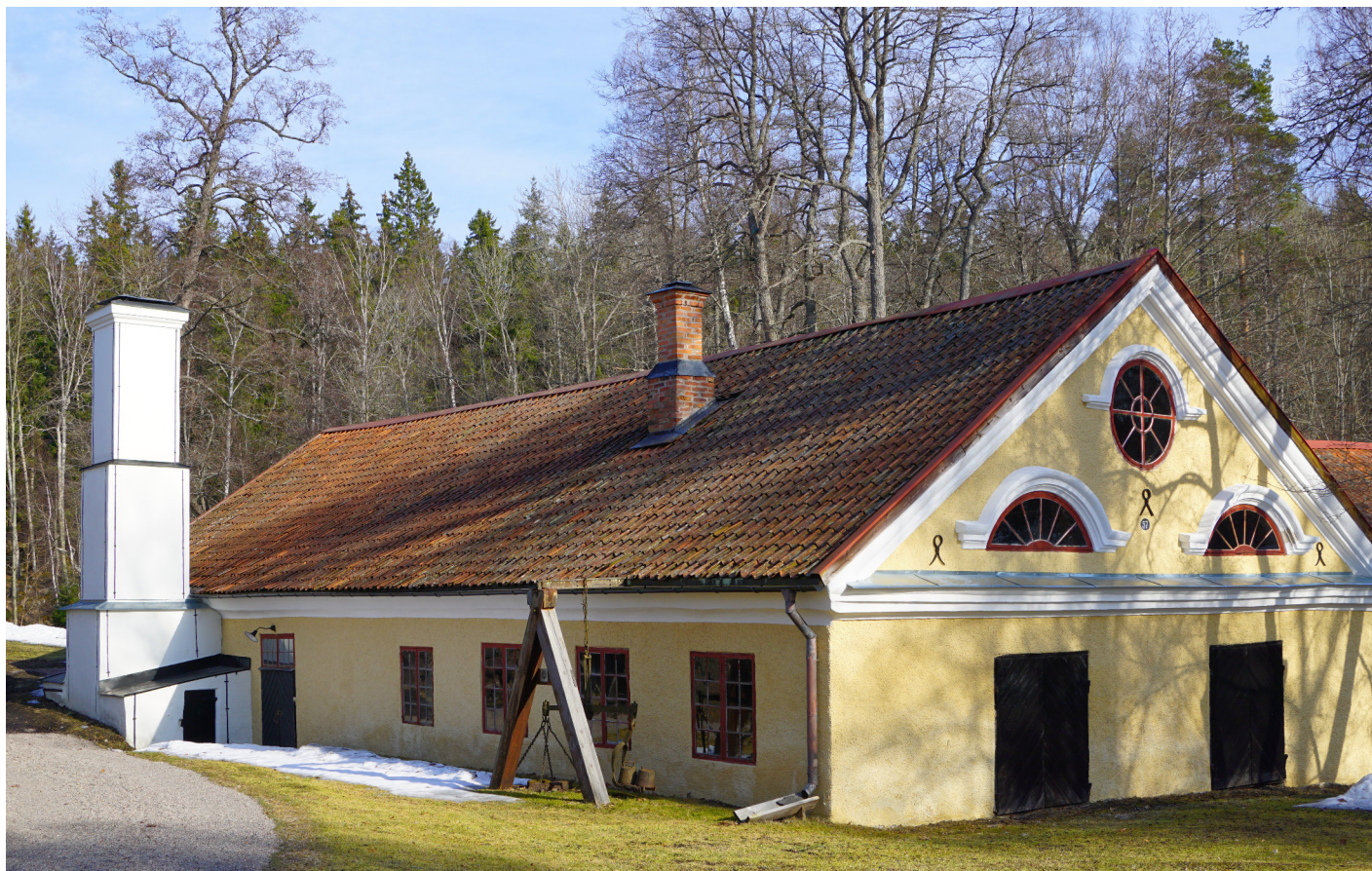
Herrsmedjan vid Engelsbergs bruk sett från sydväst. Se den smyckade gaveln och den vita skorstenen med gnisterhus som släcker de gnistor vilka finns i lancashirehärdarnas avgaser från smedjan.
