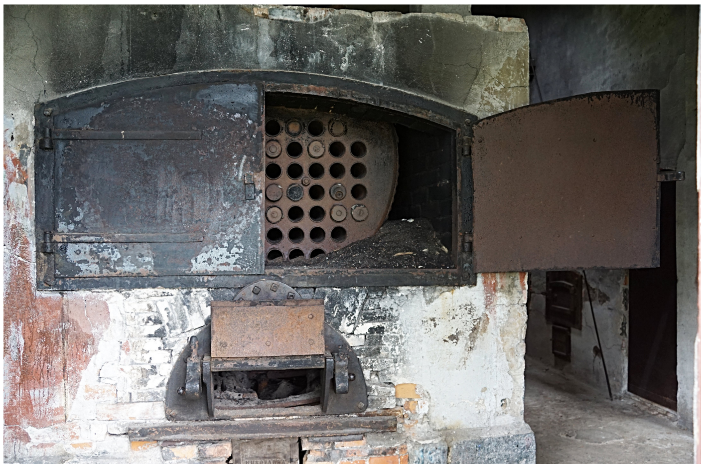
Ångpannan i oljefabriken är av eldrörstyp. De heta rökgaserna från eldstaden undertill passerar rör (tuber) som går genom pannans vattentank.
