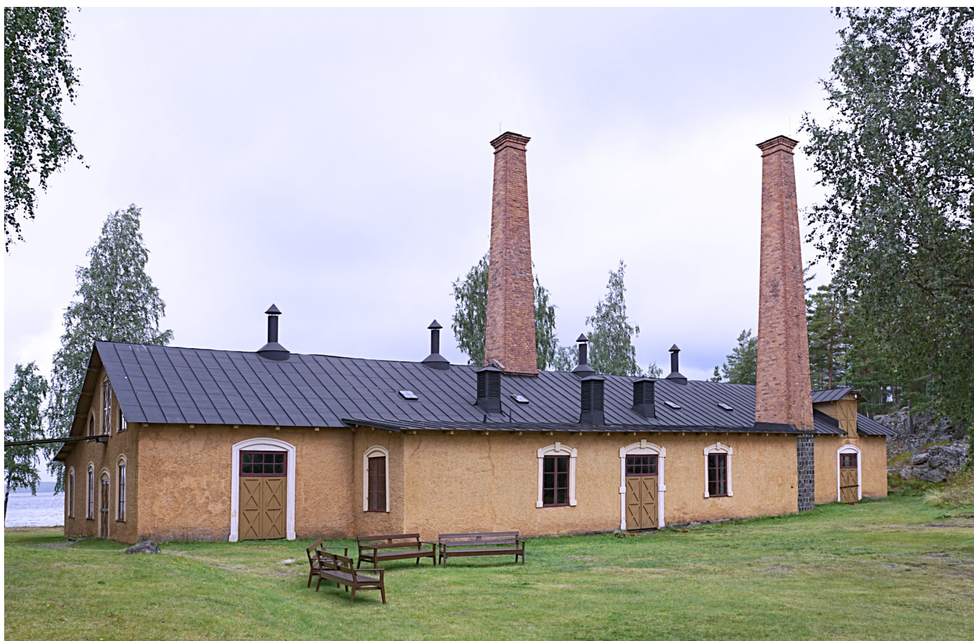
Oljefabriken fotograferad från öster. Den högra skorstenen och byggnadsdelen till höger byggdes 1889.
